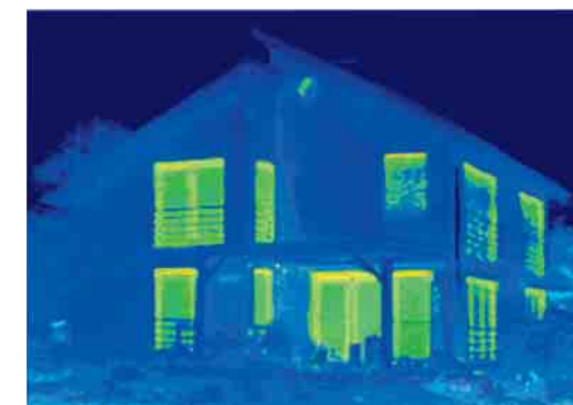
Nach dem sorgfältigen Einbau neuer Fenster aus dem Schüco LivIng Fenstersystem beweist die Thermografie den hohen energetischen Nutzen der Investition. Der ursprüngliche Energieverlust wird nahezu vollständig vermieden.
